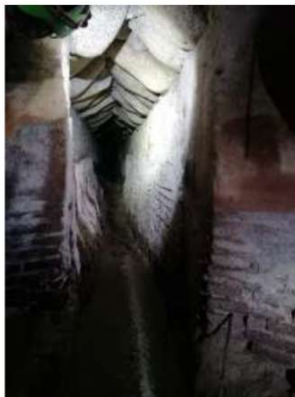
1. Galleria di intercettazione della falda. Qanat di Anioia
